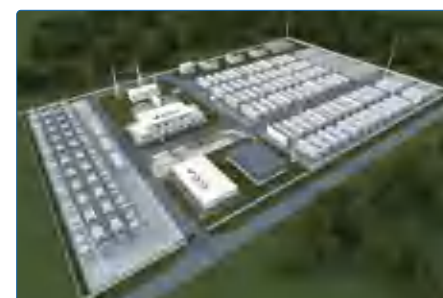
华电灌云200MW/400MWh储能电站
