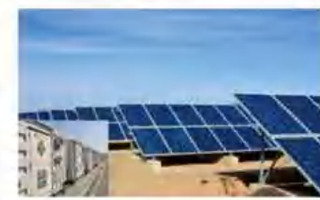
青海光伏发电侧项目
