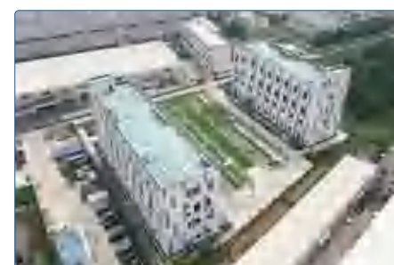
苏州中低压直流配用电系统示范工程
