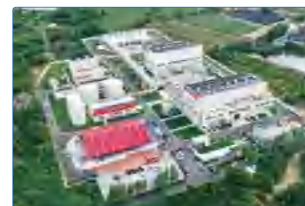
江苏井盐穴压缩空气储能 发电系统国家示范项目
